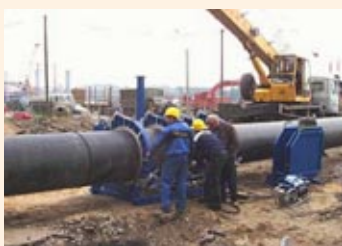
Применение ПЭ трубы при строительстве сетей напорного водоснабжения, Санкт-Петербург
