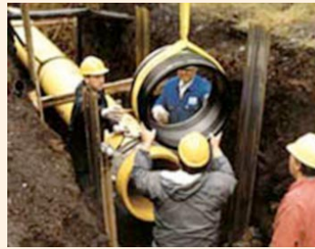
Западная Европа: работы по строительству ПЭ-газопровода большого диаметра
