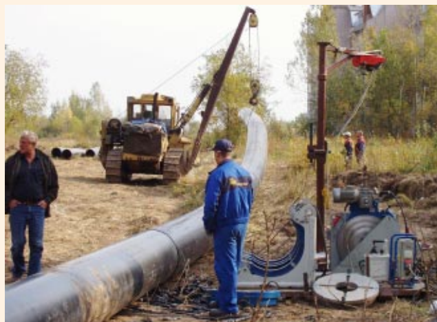
Великий Новгород, 2005 г. МУП «Водоканал» ведет работы по замене изношенных коммуникаций на современный надежный трубопровод из ПЭ 100.
