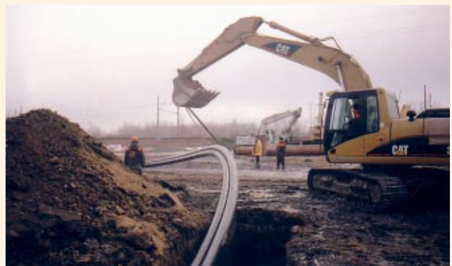
Применение ПЭ труб при строительстве сетей напорного водоотведения. Санкт-Петербург, Таллинское шоссе
